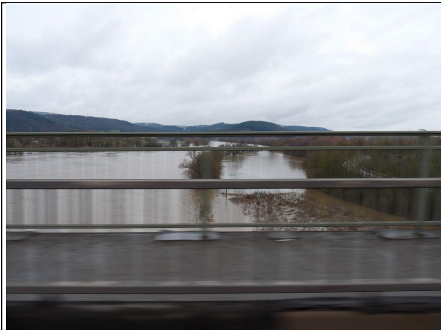
Bild 4: rechtes Moselufer unterhalb der Ehranger Brücke mit überflutetem Acker. (Aufnahme aus dem fahrenden Auto)
