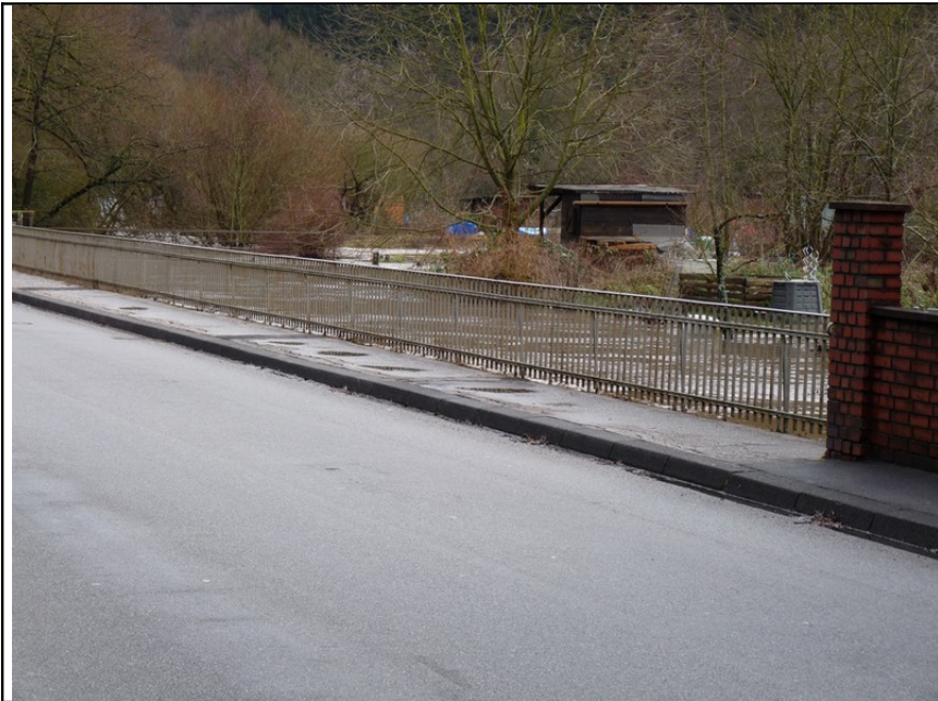
Bild 10: Abzweigstelle der neuen Trasse
