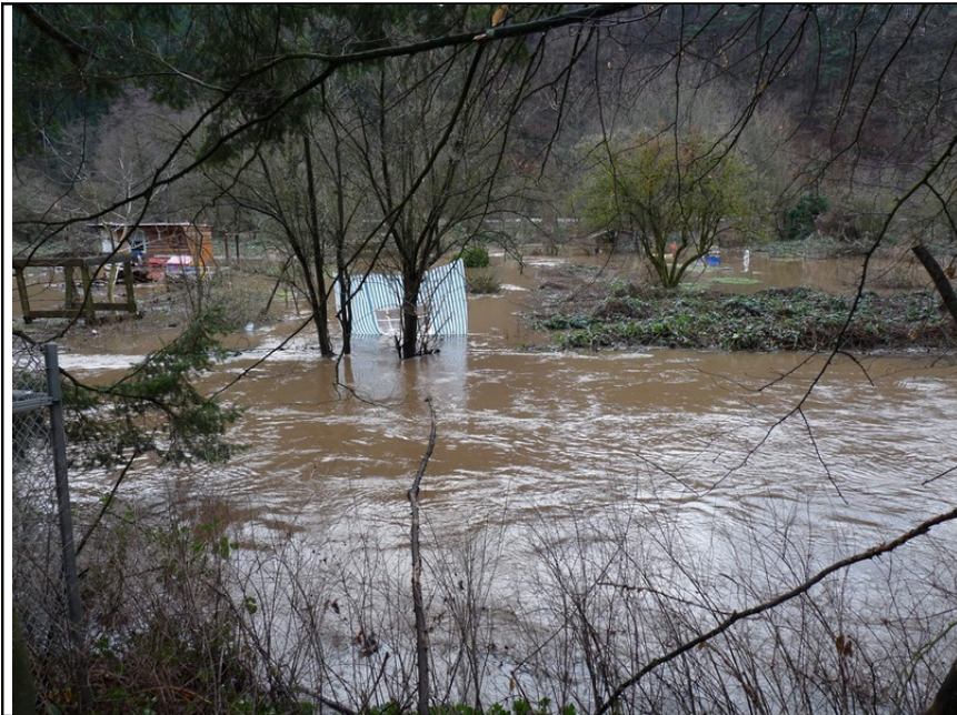
Bild 4: Mühleninsel. Im Vordergrund der überflutete Mühlenbach, auf dem die zukünftige Trasse der B422 auf einem hochwassersicheren Damm geführt werden soll.
