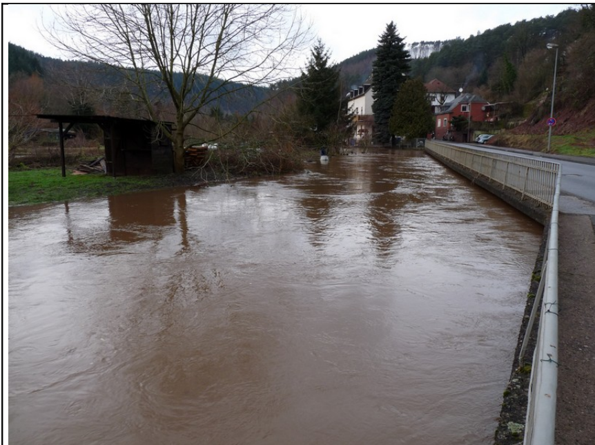
Bild 8: Überfluteter Mühlenbach; hier soll die neue Trasse von der alten Trasse der B422 abzweigen und auf einem hochwassersicheren Damm geführt werden. Durch den Verbrauch an Retentionsvolumen und der Verkleinerung des Abflussquerschnitts werden die oberhalb liegenden Häuser zukünftig durch Hochwasser stärker belastet.
