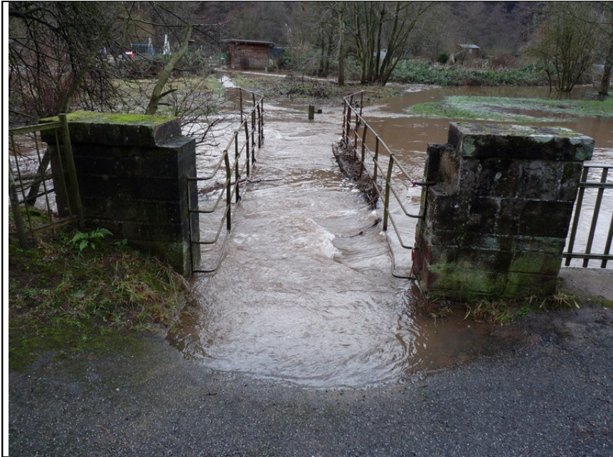
Bild 7: Überfluteter Steg zur Mühleninsel
